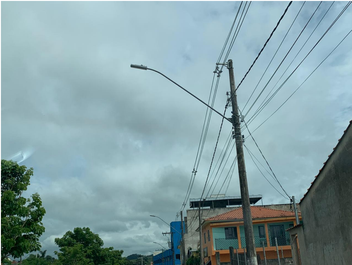
1 Substituição por Lâmpadas de Led
