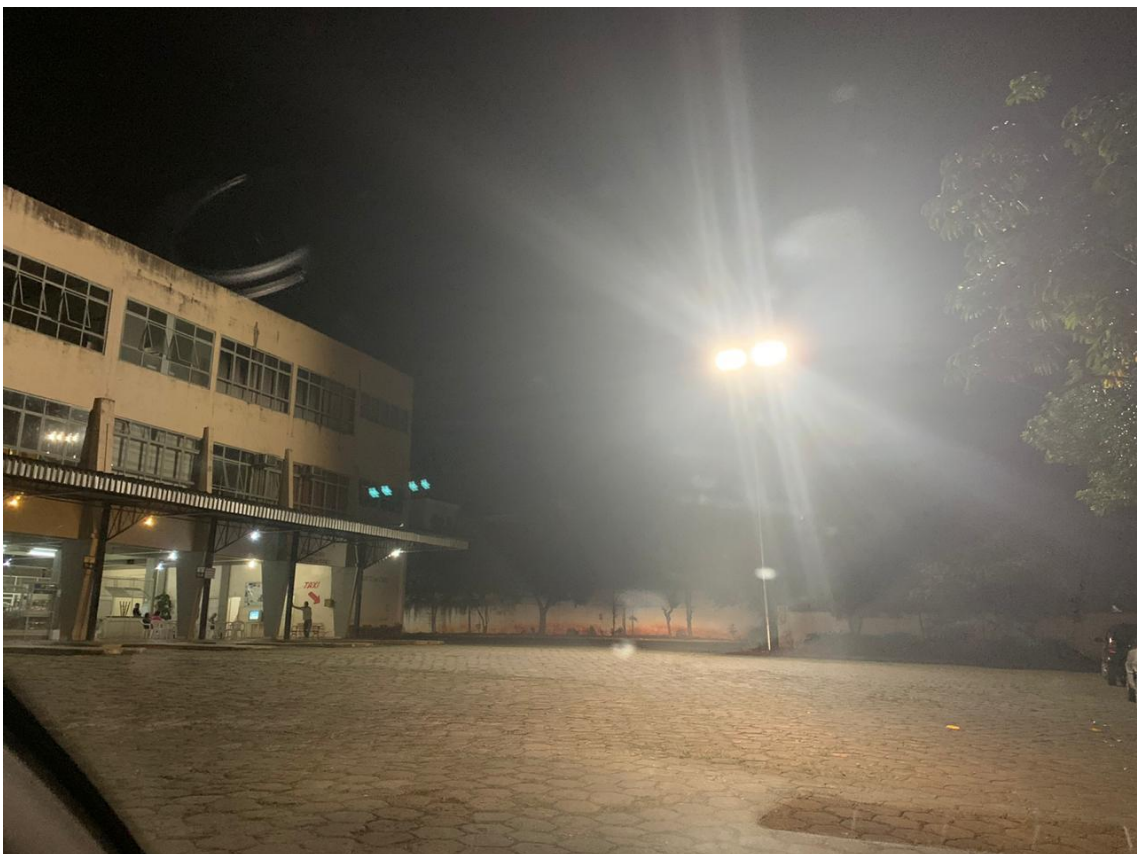
4 Colocação de Lampadas de Led na Rodoviária Municipal
