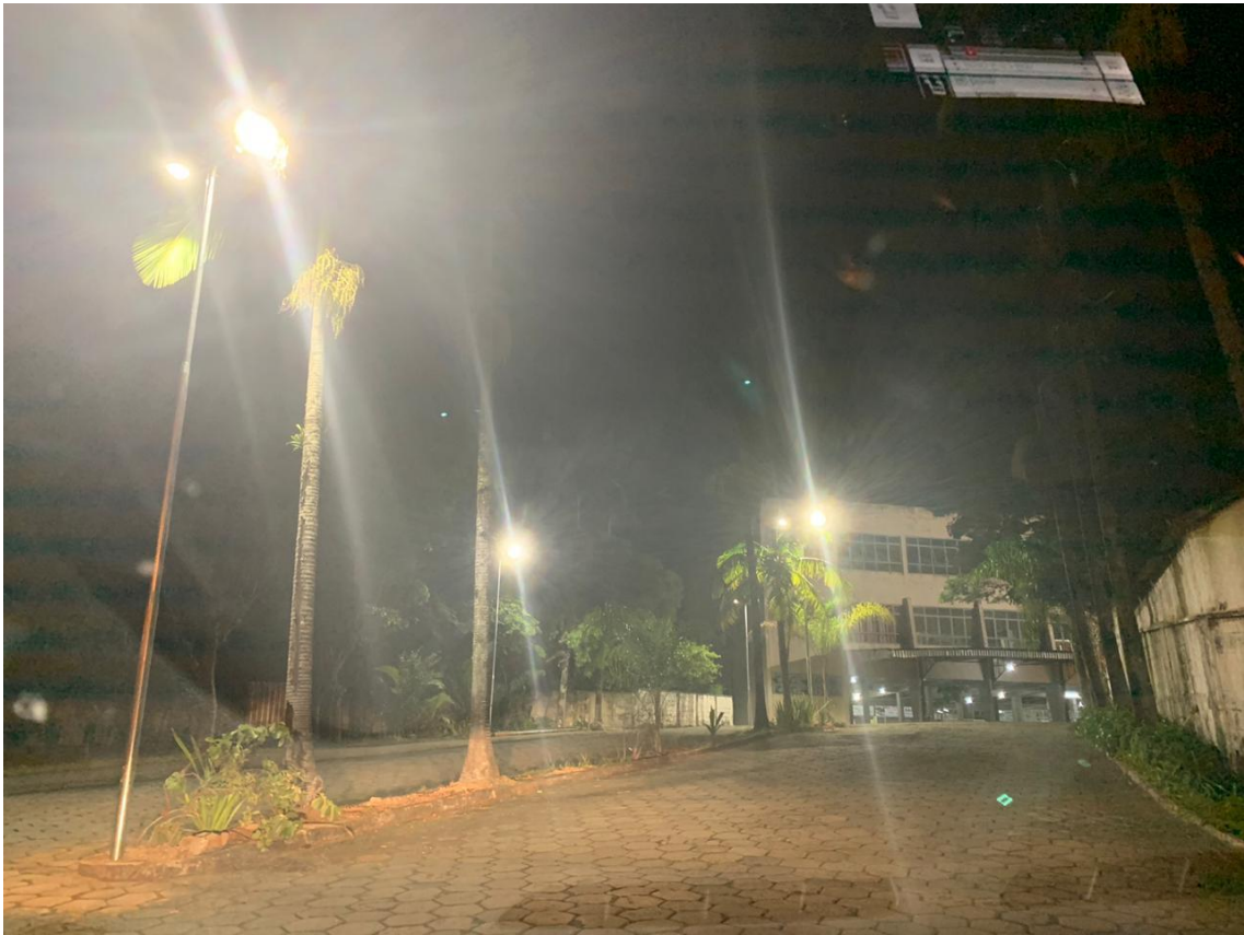
5 Colocação de Lâmpadas de Led na Rodoviária Municipal
